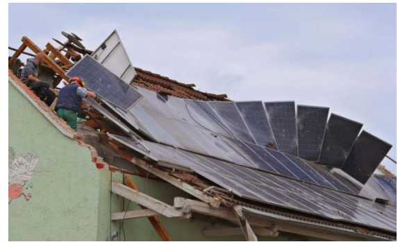
竜巻で屋根が破損。太陽光パネルも剥ぎ取られている。 Augsburg 13.05.2015 BR Nachricht より引用
