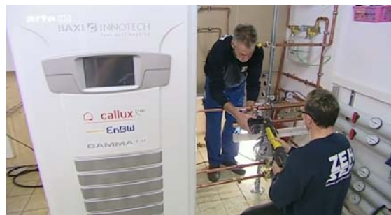
Baden-Württemberg 州のエネルギーコンツェルン助成の家庭用水素ガスジェネレータの設置
