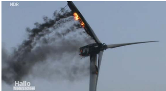
最近多くおきる落雷による CFRP 製の風力発電用プロペラの炎上
